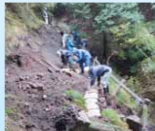
▲山内自治振興会ボランティアチームによる東海自然歩道復旧作業
